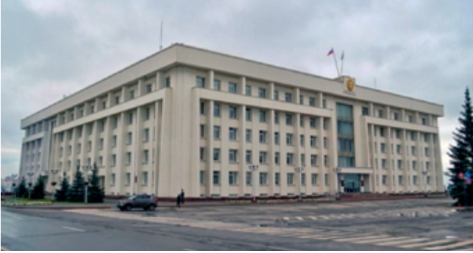
Здание Башкирского обкома КПСС, ныне – Администрация главы Башкирии
